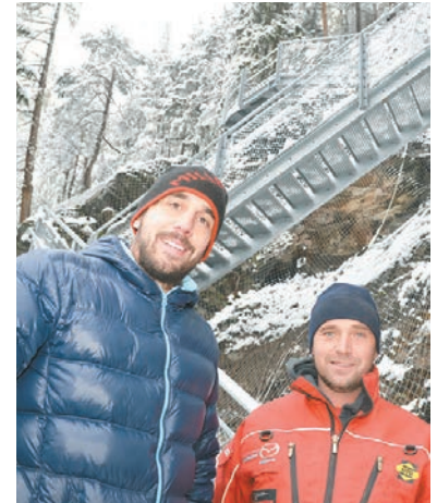
„HTB“-Bauleiter Armin Krabichler und Polier Andreas Pinzger sind mit dem Baufortschritt zufrieden. RS-Foto: Schnöll
