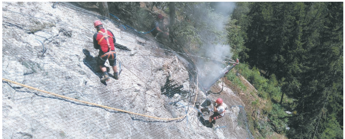
Mehrere Wochen lang mussten die „HTB“-Spezialisten am Seil hängend die Anker für die Stahltreppe in den Fels treiben und Steinschlagnetze anbringen. Foto: Götsch WERBEGRAFIK & DESIGN
