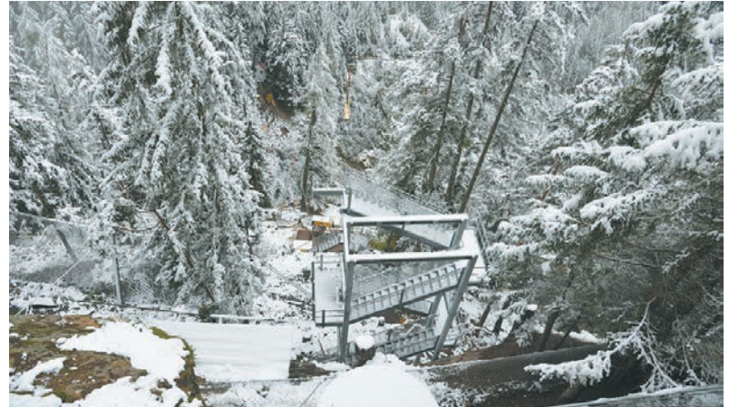
Die schwer zugängliche Baustelle für die Stahlhängebrücke und die Stahltreppe. Die Baumaterialien müssen mit Seilbahnen antransportiert werden. RS-Foto: Schnöll
