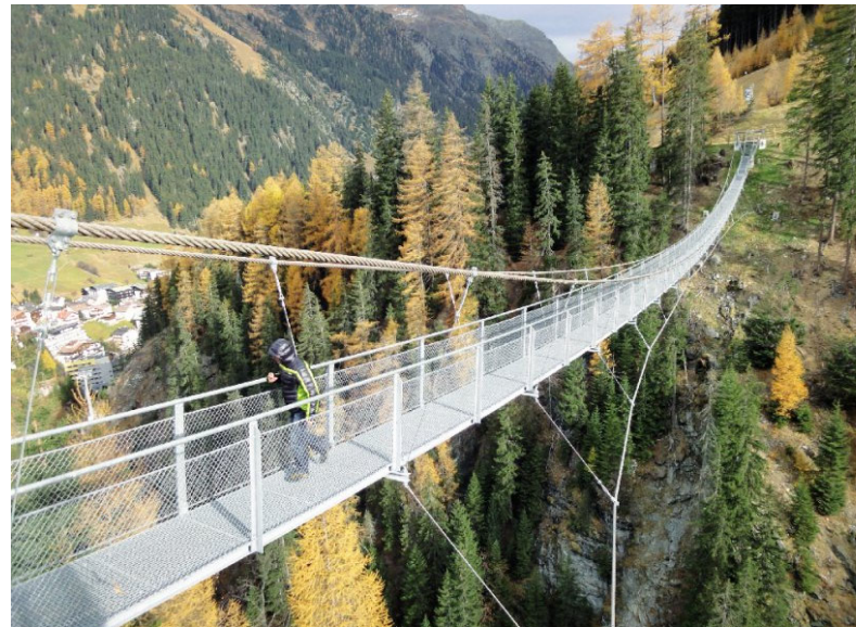
Das Know-how von HTB wird auch immer öfter bezüglich Hängebrücken nachgefragt. Im Bild die „Bärenfalle-Brücke“ in Ischgl.
